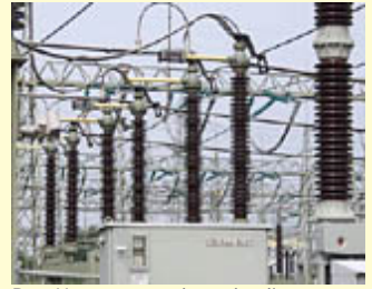
Das Umspannwerk senkt die Stromspannung für den Hausgebrauch.
